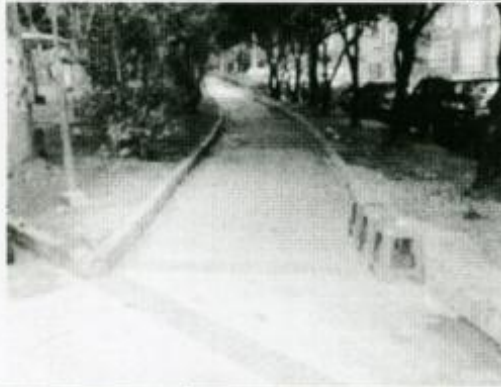
VISTA RECUPERACIÓN ANDENES EN CONCRETO CON CENEFAS Y BORDILLOS EN ADOQUIN TIPO LADRILLO
